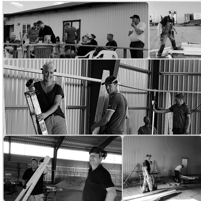
Föräldrar i full fart med byggandet i nya ridhuset.
